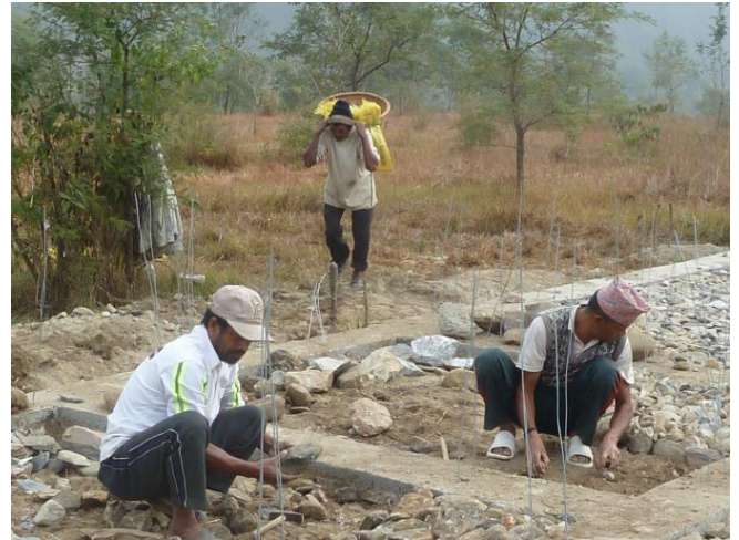
bamboe schotten en fundering leggen
